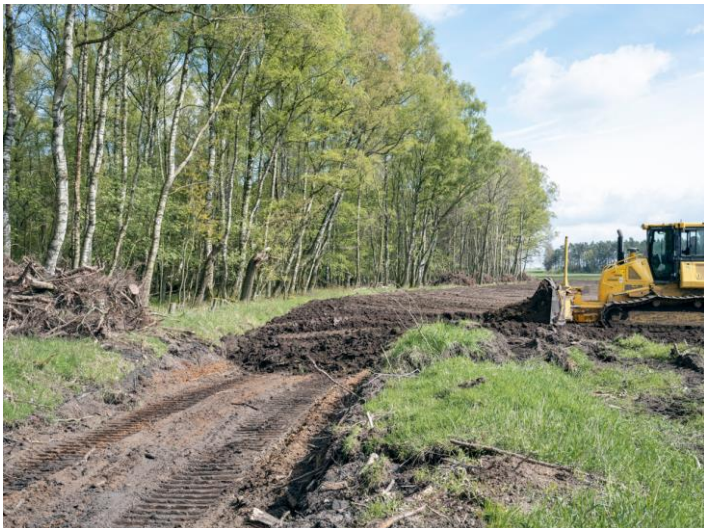
Raupenfahrzeuge bewegten 10.000 m 3 Verfüllmaterial, um den Ringgraben dem Erdreich gleich zu machen. Foto: Wolfgang Bellwinkel/laif
