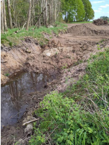
Der Ringgraben rund um das Naturschutzgebiet wurde verfüllt, damit das Wasser ungehindert dem Moor zugutekommt. Foto: Nina Seifert / Michael Succow Stiftung
